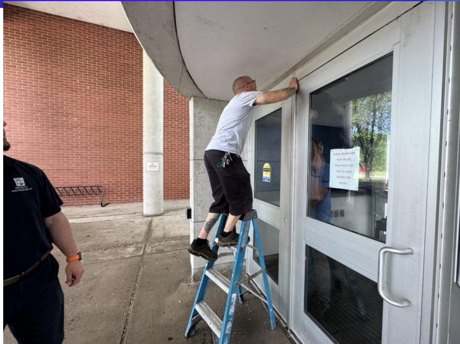
► Entry Door Repair Project
