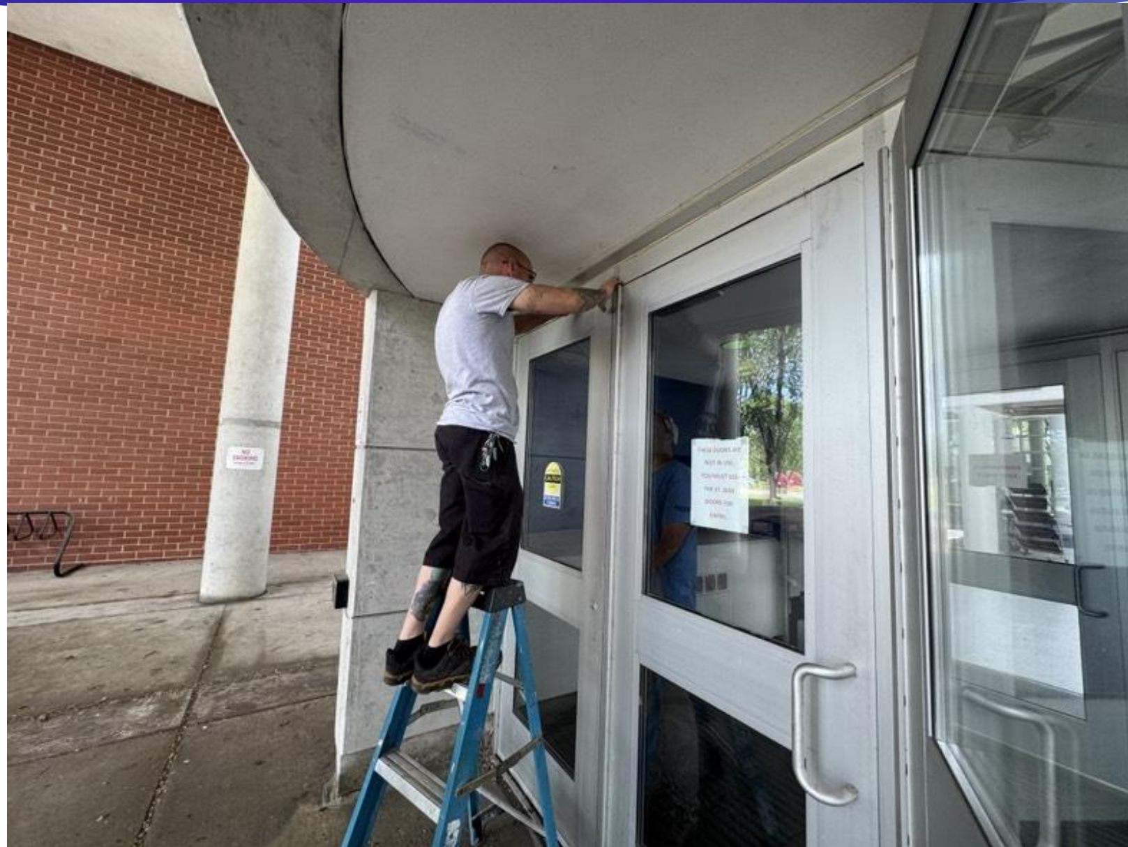
► Entry Door Repair Project
