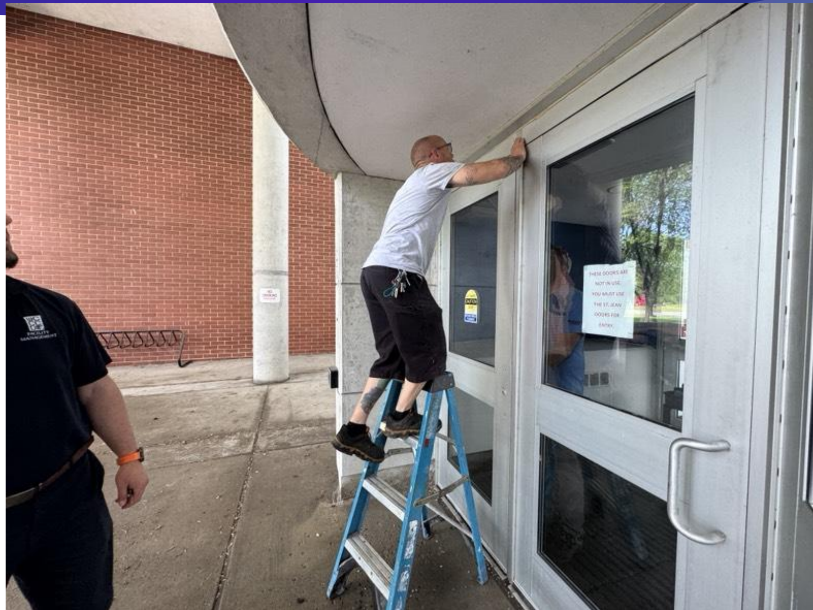
► Entry Door Repair Project
